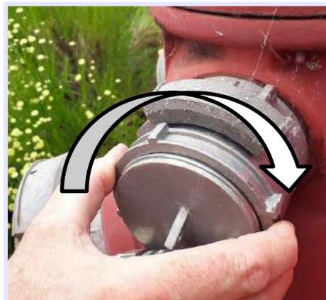
Ouvrir le poteau d'incendie et enlever le bouchon de protection. Puis, installer le bouchon fourni par Ijinus.
