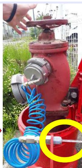
Serrer le bouchon avec la clé fournie et clipser le flexible. Clipser le raccord rapide de la clé tricoise sur l'extrémité du flexible. Ouvrir légèrement la vanne de tête du PI jusqu'à purge complète du flexible.
